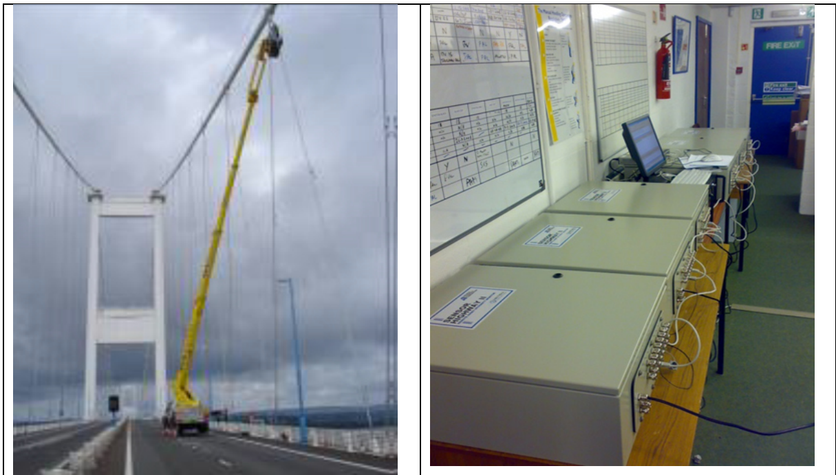
Bild 4. Installation der Sensoren an den Hängekabeln der M48 Severn River Crossing Suspension Bridge in Großbritannien (Bild links) und Ansicht des Überwachungsraumes bei MISTRAS UK (Bild rechts).
