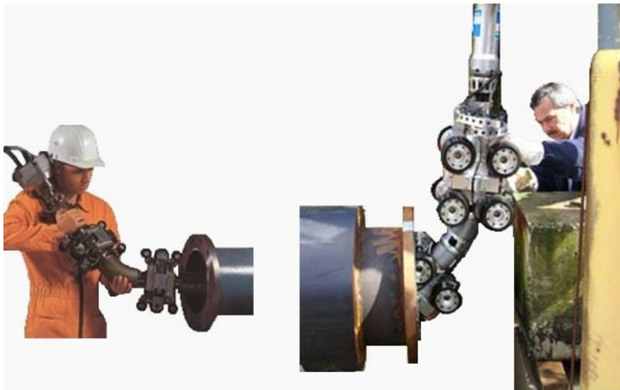
Abb. 7. Einsetzen von Rohrroboter in eine Rohrleitung
