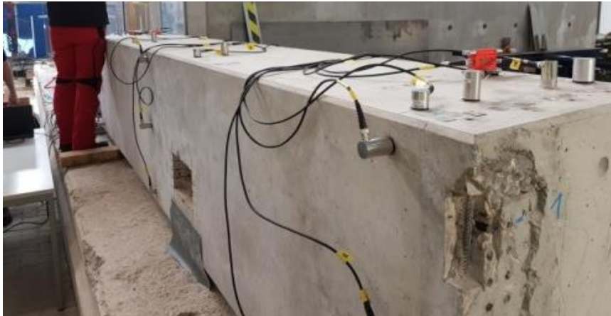
Abb. 1. Beispiel eines Vorversuchs zur Detektion von Spannstahlrissen an einem Betonkörper. Es wurden verschiedene Schallemissionssensoren und Vorverstärkungen getestet. Die Spannstähle wurden durchgeschnitten und über elektrochemische Korrosion „durchgerostet“
