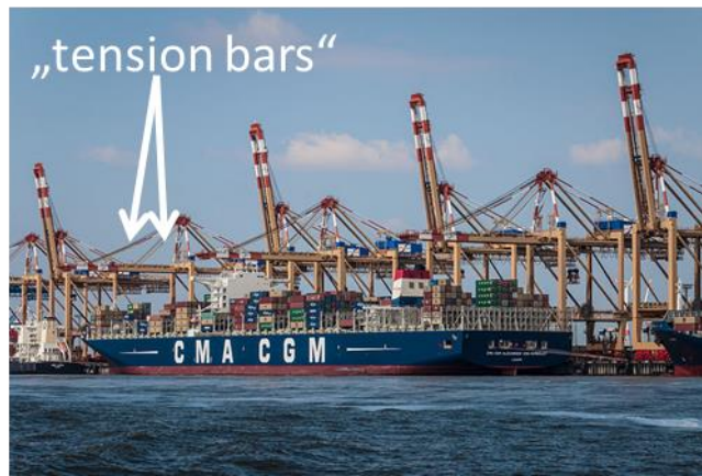
Abb. 2. Beispiel von Containerkränen im Betrieb. Die Kranausleger sind teilweise hochgeklappt. "tension bars" sind bei einem Kran durch die weißen Pfeile gekennzeichnet [5]
