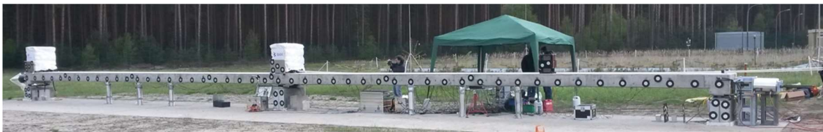
Abb. 1. Gesamtansicht der Modellbrücke auf dem Testgelände der BAM.
