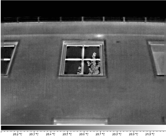
Abb. 11: Das Resultat ist der Mittelwert aus 20 Einzelthermogrammen, wobei jedes einzelne vorher mit dem Shutter der IR-Kamera abgeglichen und vor dem Überlagern mit der Bildebgebung behandelt wurde. Der Span des Thermogramms liegt nur noch bei einem einzigen Grad.
