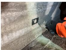
1. Betonoberfläche abrasiv entfernen (Glätten, Reinigen der Oberfläche)
