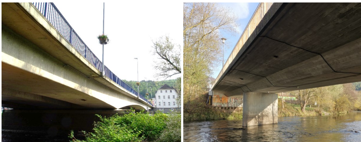
Abb. 2. Stennertbrücke in Hagen (links) und Werrabrücke in Walldorf (rechts).
