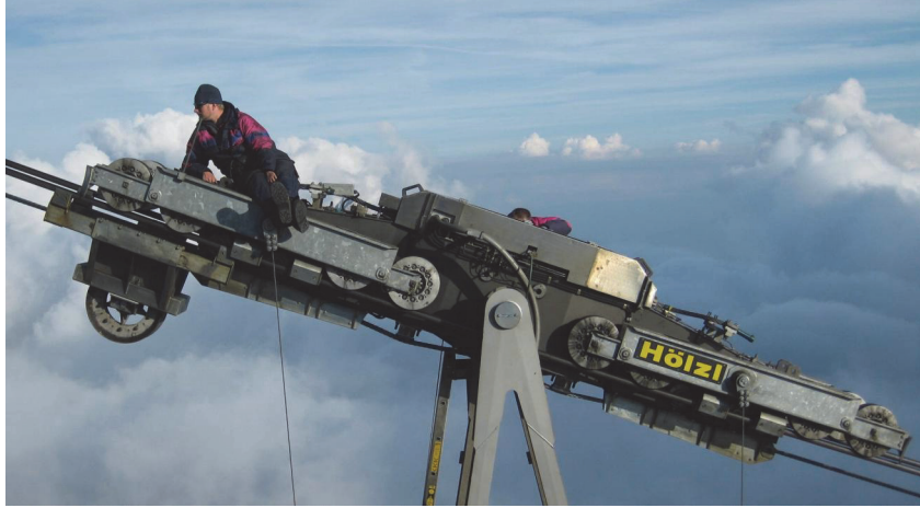
Arbeitsplatz: Prüfung in 500m Höhe
