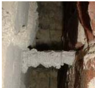
sachgerecht ausgeführte Vernadelung
