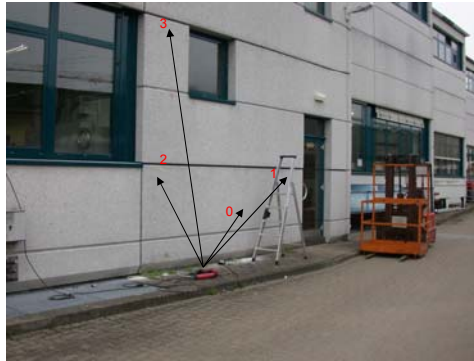
Westfassade mit Markierung der Bohrungen für die Endoskopien auf der Fassade
