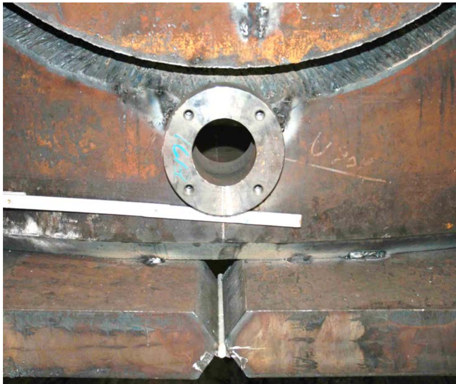
Bild 3. Nahtvorbereitung mangelhaft, Schweiß- und Zusammenbaufolge nicht beachtet.
