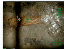
Bestimmung der Tiefe des Wurzelrückfalls
