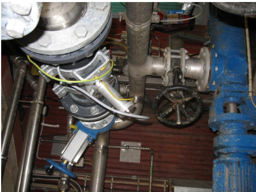
Abb. 7 Mikrowellen-TS-Sensor MWTS PP tube in einer Abfallvergärungsanlage
