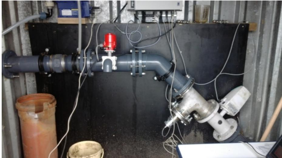
Abb. 8 Mikrowellen-TS-Sensor MWTS PP guard TK zur TS-Messung in Teich- und Gewässerschlamm
