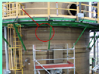
GFK-Absorberturm einer Raffinerie
