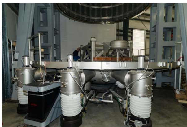
Feinvakuumssystem und Lecksucheinheit (im Hintergrund die Tragstruktur für die Spule)
