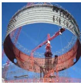
Einheben eines Liner-Doppelschusses beim neuen EPR Reaktor OL 3 Finnland
