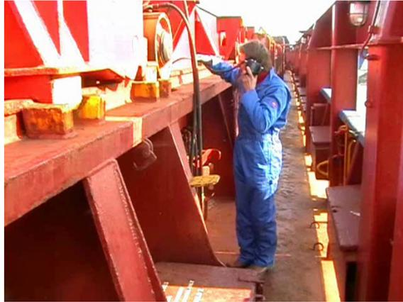
Dichtheitsprüfung beim Schiffsbau
