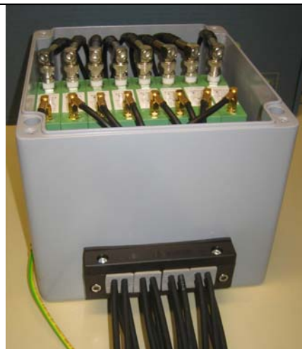
Bild 5 – HISO3 offen, mit Kabeleinführung
